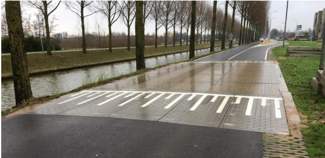
Figuur 31: Een verkeersplateau met een helling van 2,40 meter. Bron: Giverbo.
