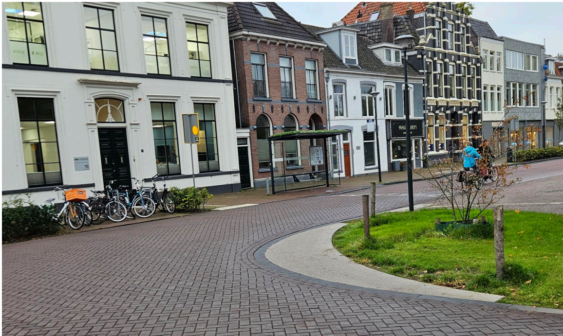
Figuur 21: Duidelijk zichtbare bochtverbreding van beton. Bron: OV-bureau.
