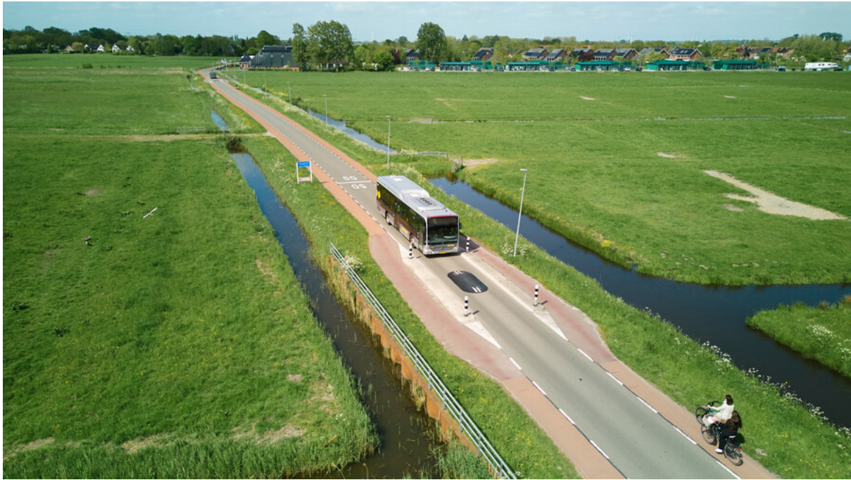
Figuur 34: De versmalling aan de Laageweg ten zuiden van de wijk Gravenburg. In het midden is een Berlijns kussen geplaatst en fietsers kunnen aan weerszijden passeren. Bron: OV-bureau.
