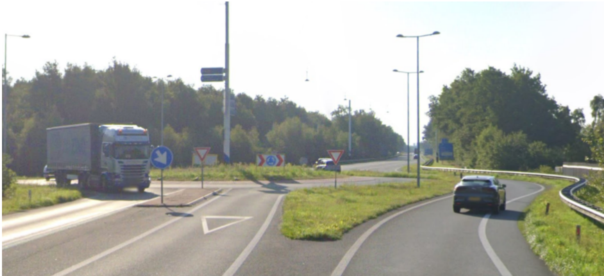
Figuur 23: Aansluiting N381 en A28 bij Beilen met een bypass. Foto: Google Streetview.
