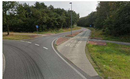
Figuur 26: Ook de rotonde af kent een busbaan(tje). Deze beperkt een extra bocht en is comfortabeler voor reizigers. Foto: Google Streetview
