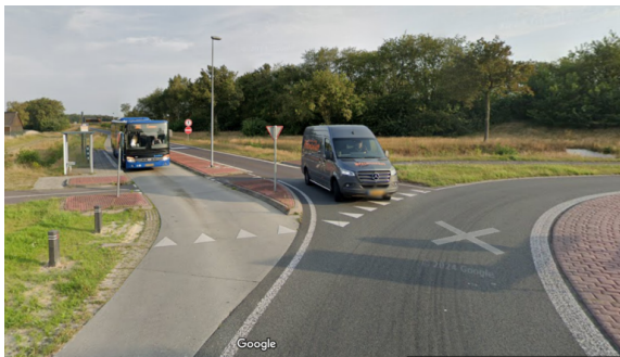
Figuur 25: Bij de aansluiting óp de rotonde is de voorrangssituatie niet even helder. Foto: Google Streetview.
