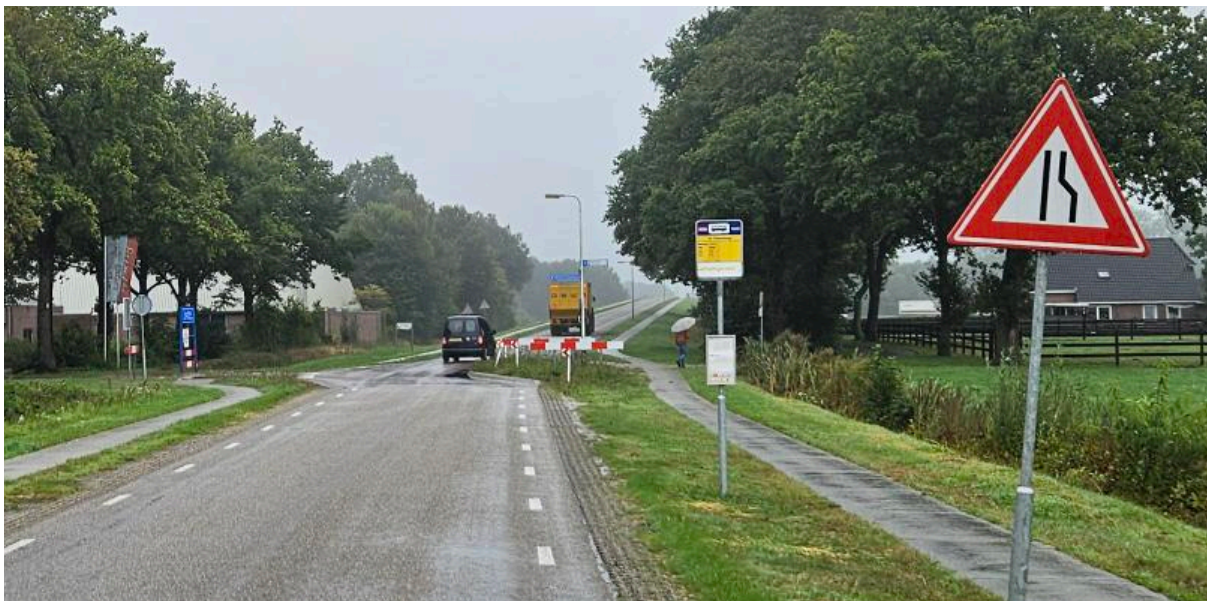
Figuur 35: In de wijk is recentelijk een asverspringing op een kruising toegepast. Bij een lichte verspringing ondervindt de bus hiervan weinig hinder. Het snelheidsremmend effect is mogelijk minder dan bij een plateau. Bron: OV-bureau.
