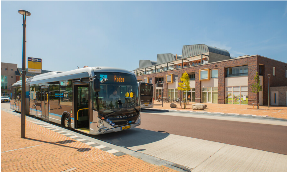
Figuur 17: Buslijn 4 bij halte Centrum in Roden, waarbij beton als verharding in de haltekomp is toegepast. Bron: OV-bureau.
