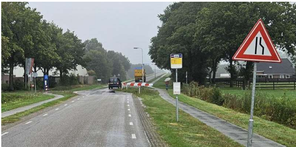
Figuur 34: In de wijk is recentelijk een asverspringing op een kruising toegepast. Bij een lichte verspringing ondervindt de bus hiervan weinig hinder. Het snelheidsremmend effect is mogelijk minder dan bij een plateau. Bron: OV-bureau.
