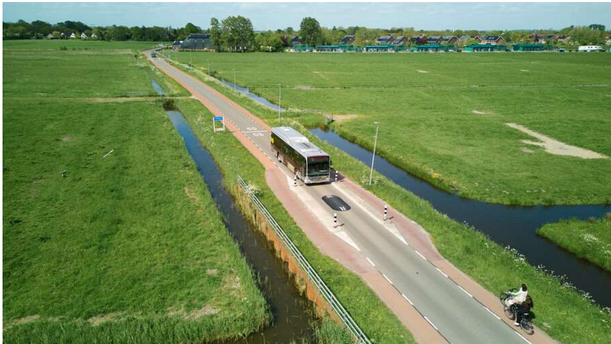
Figuur 33: De versmalling aan de Laageweg ten zuiden van de wijk Gravenburg. In het midden is een Berlijn's kussen geplaatst en fietsers kunnen aan weerszijden passeren. Bron: OV-bureau.
