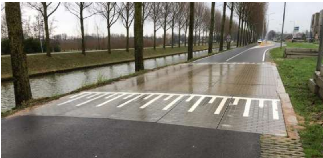
Figuur 30: Een verkeersplateau met een helling van 2,40 meter. Bron: Giverbo.
