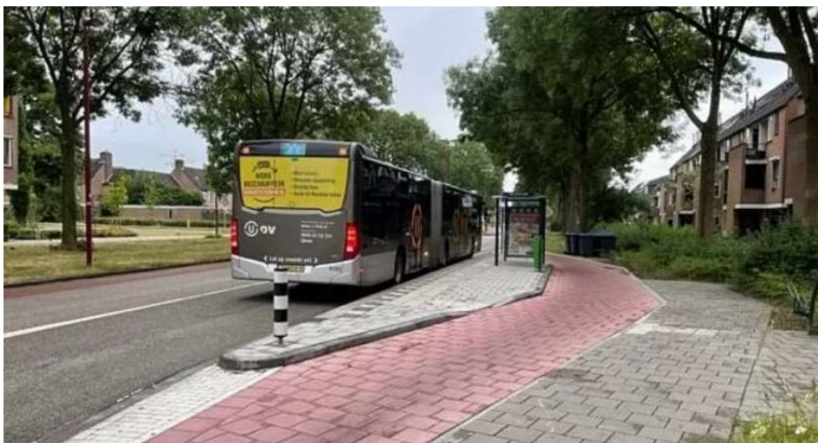
Figuur 18: Fietspad loopt achter de halte langs in Utrecht. Voordeel van een dergelijke oplossing is dat de bus bij het verlaten van de haltekom niet een fietspad hoeft te doorkruisen of fietser niet achter de bus hoeft te wachten. Bron: Gemeente Nieuwegein.
