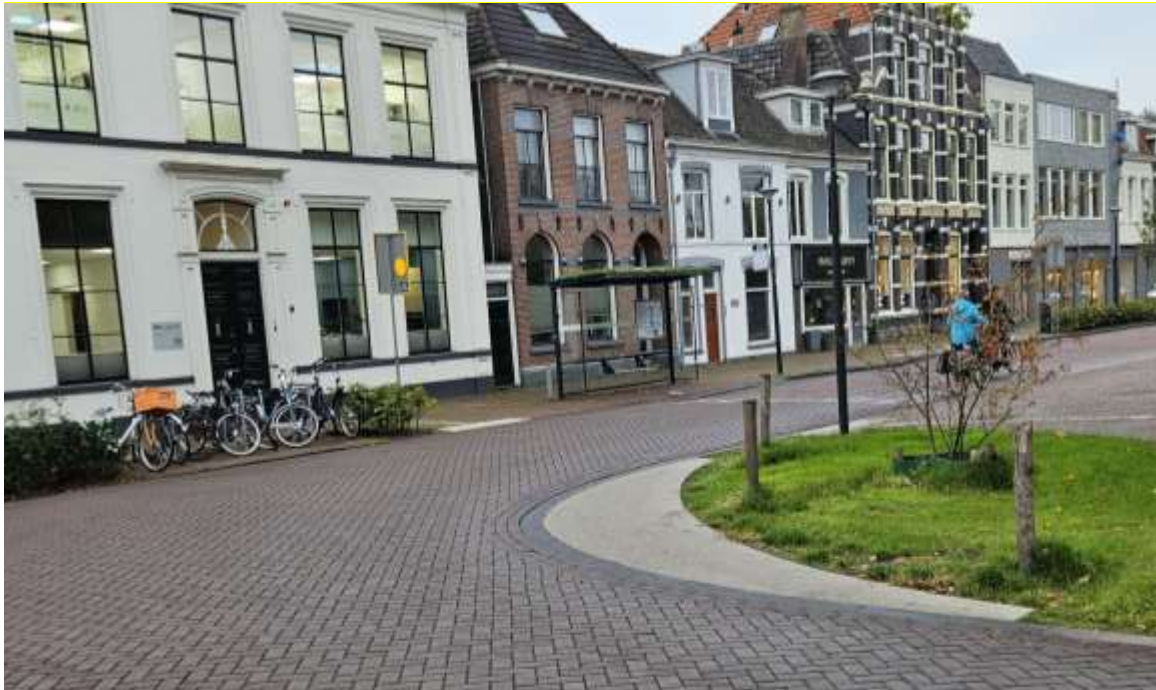
Figuur 21: Duidelijk zichtbare bochtverbreiding van beton. Bron: OV-bureau.
