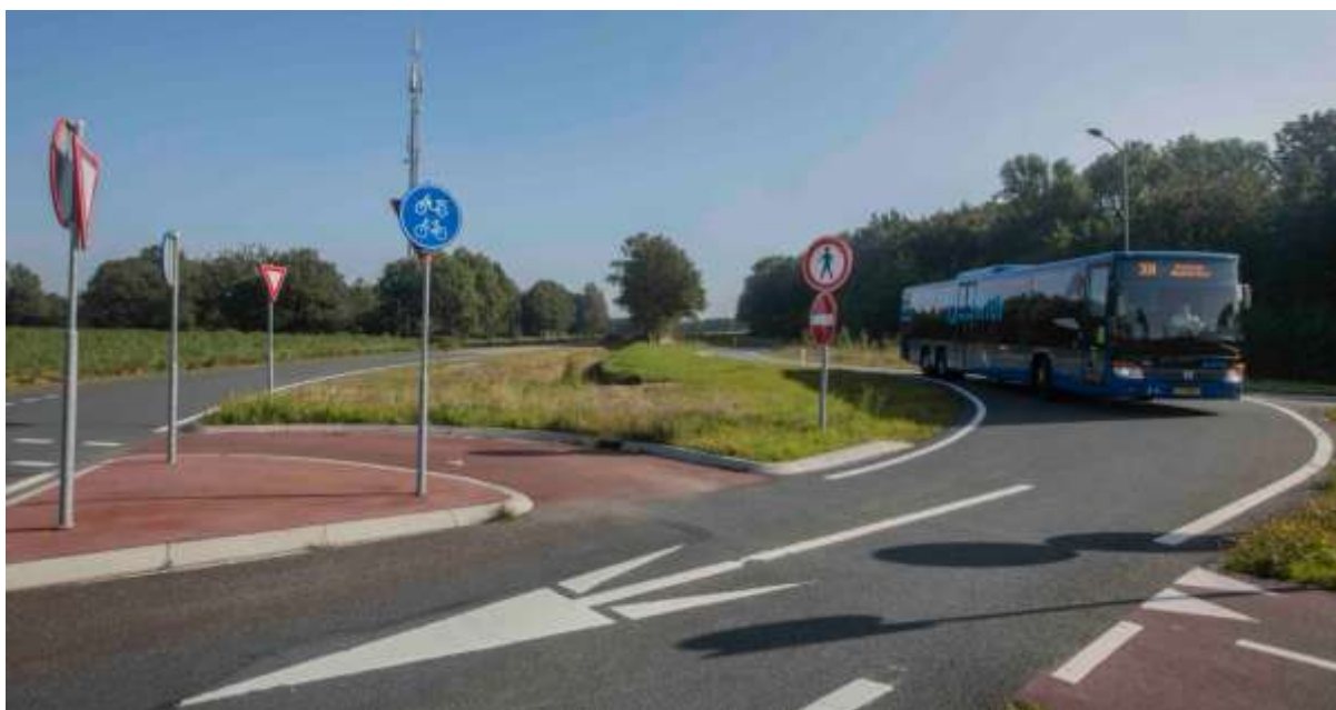
Figuur 19: Qliner in bocht. Een voertuig van 15m heeft een grotere draaicirkel én uitzwaai dan een standaardbus. Let daarop bij de dimensionering van de weg, maar ook de plaatsing van obstakels langs de route. Bron: OV-bureau.
